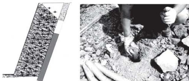
**Рис. 1.** Расположение воздушного баллона скважинного заряда
